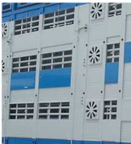
Rys. 9 – Żaluzje wentylacyjne sterowane automatycznie
